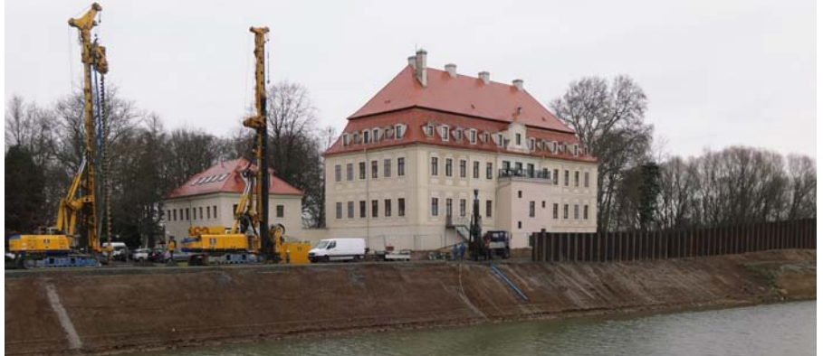
▲ Erweiterung der bestehenden Hochwasserschutzanlagen (Stahlpundwand) am Schloss Gröba in Riesa
