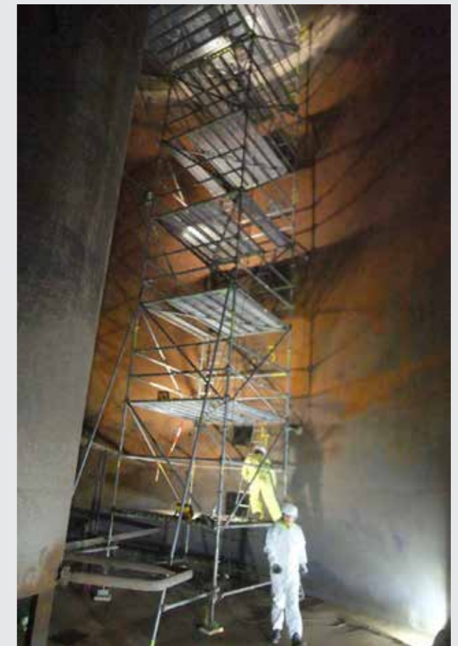
Revision der Fermenter der BioCo-Vergärungsanlage Radeberg (Sachsen) nach 17 Jahren Betrieb
