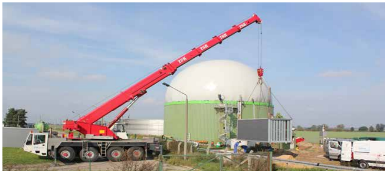
Flexibilisierung der BGA Selbitz (Sachsen-Anhalt): ein neues Foliengaslager ist bereits installiert, das zusätzliche BHKW befindet sich im Aufbau
