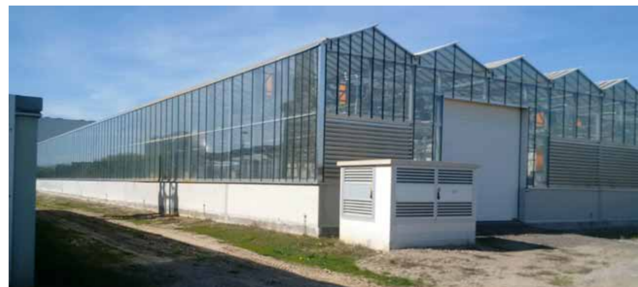
Solartrocknungsanlage auf der BGA Binder (Forchheim, Bayern)
