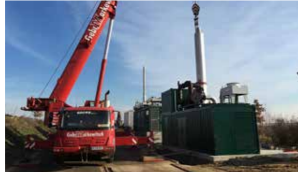
Installation eines Flex-BHKW
