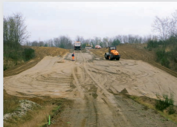
Wegebau – Abflachung der Einfahrt in einer Talsenke
