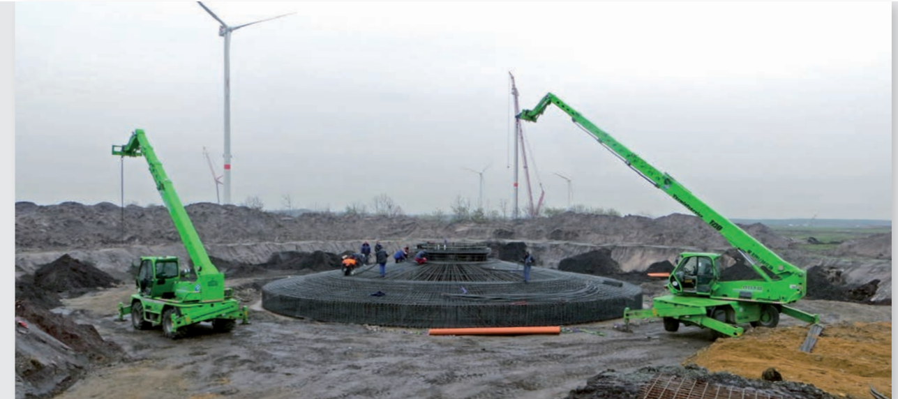
Montage der Fundamentbewehrung auf der Windparkbaustelle Klettwitz
