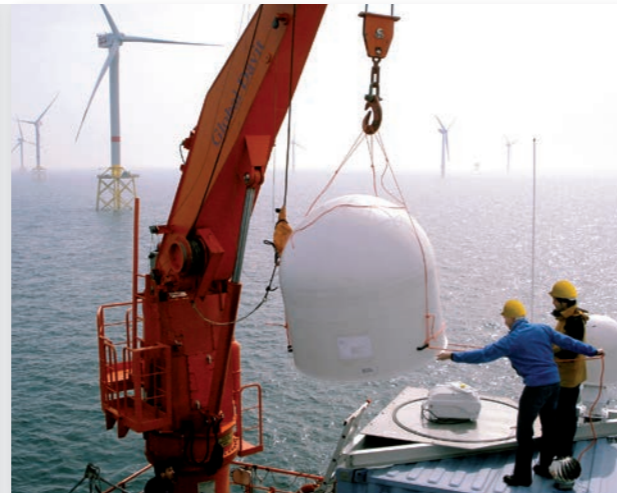
Montage des GICON/IfaÖ-Radarsystems zur Vogelzugbeobachtung
