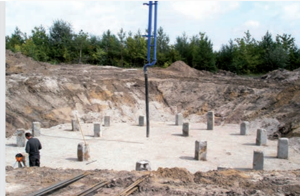
Eingebaute Rammpfähle auf dem Windpark Cottbus Nord
