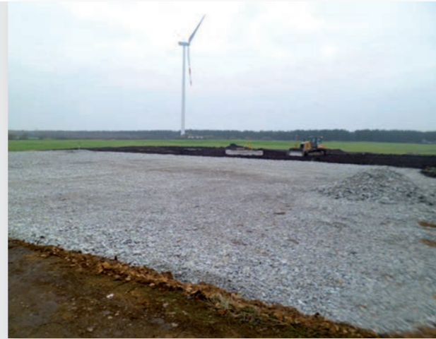
Herstellung einer Kranaufstellfläche
